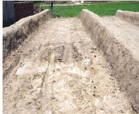
Kaccha Bunker Silo
